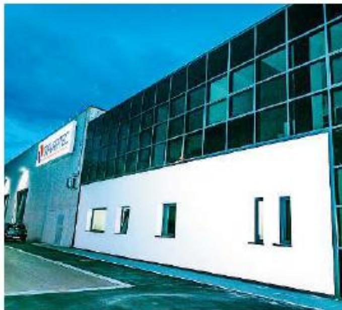
Il nuovo stabilimento. A Rodengo Saiano la sede della Travar Tec srl
